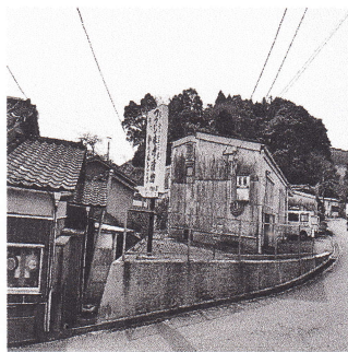
昭和62年建設 老朽化した農産物加工場
